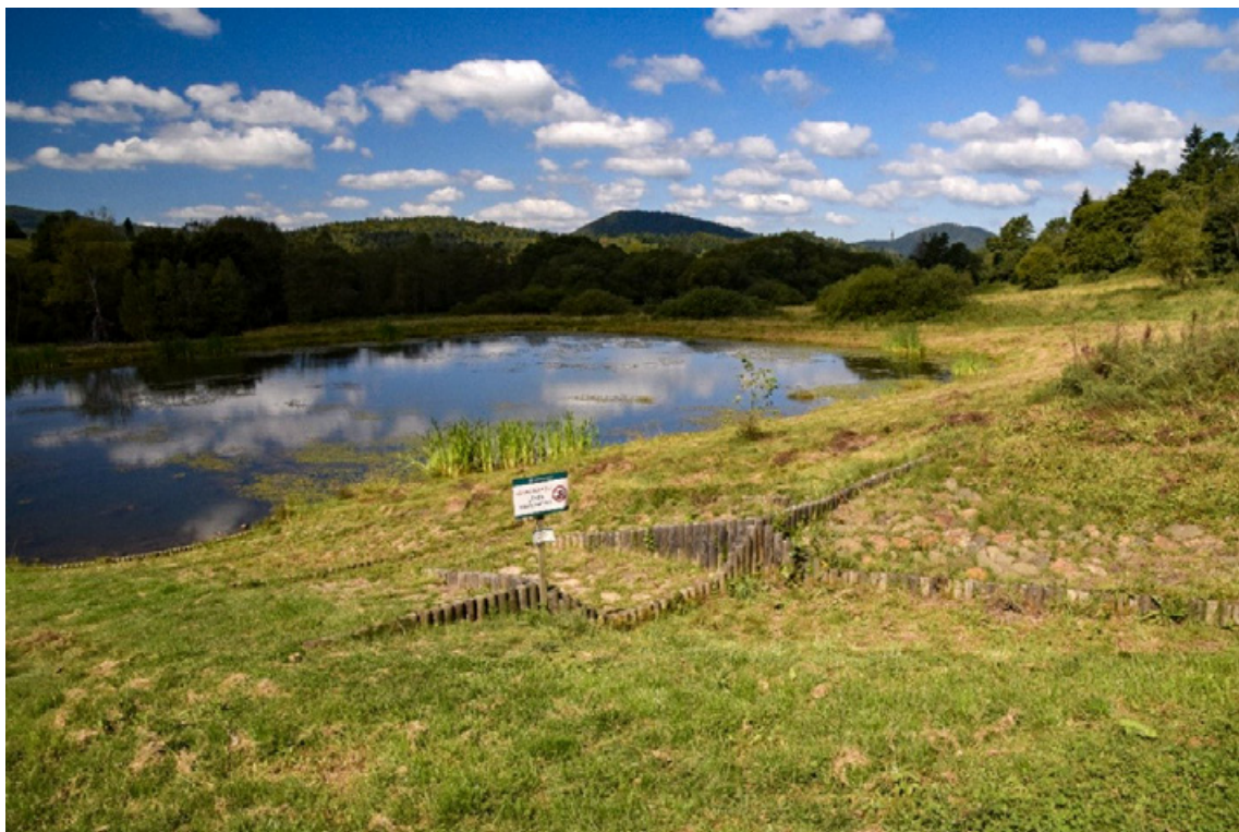
Fot. 119. Końcowy zbiornik w układzie kaskadowym w Nadleśnictwie Baligród zasilanym z ciek, a dodatkowo także wodą doprowadzoną z rowu przydrożnego – na pierwszym planie widoczne miejsce zasilania zbiornika wodą z rowu (fot. M. Mikulska)
