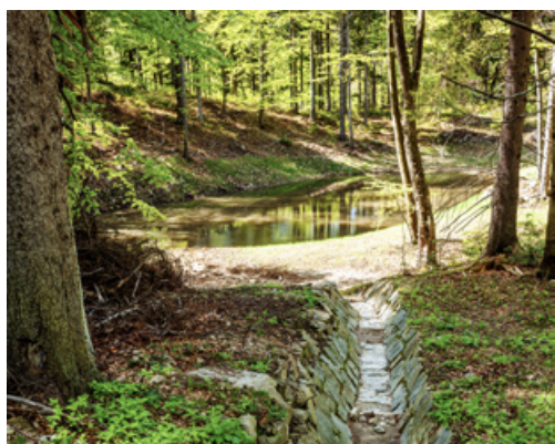
Fot. 14. Zbiornik zasilany spływami powierzchniowymi, w tym korytem kierującym wodę z wysokości lub drogi w Nadleśnictwie Piwniczna, 2015 (archiwum CKPŚ)
